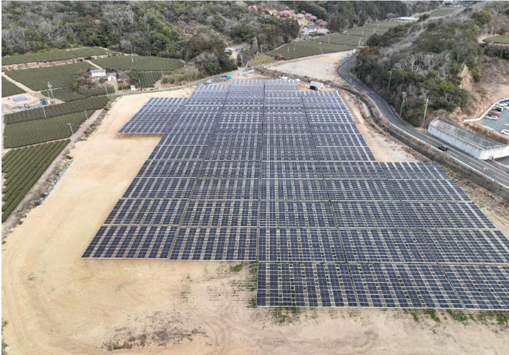
【本発電所の現況写真（※2023年3月時点）】
