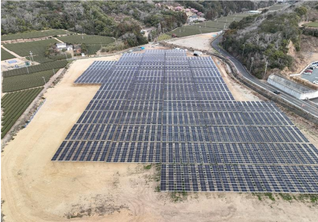
【本発電所の現況写真（※2023年3月時点）】
